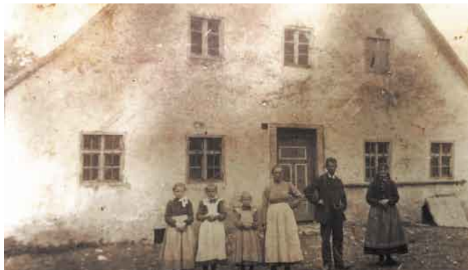
Bild 2: Ansicht des alten Hauses.
