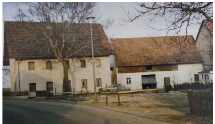
Bild 4: Ansicht des in 2000 abgerissenen Hauses. Sigmund und Brigitte Geier ersetzten es mit einem Neubau und bauten das anrainende Gebäude in eine Metzgerei um.
