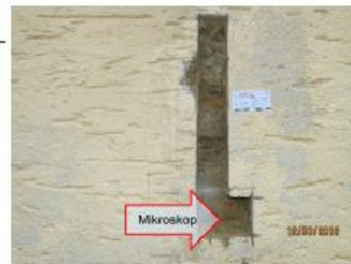
Detailaufnahme Putzaufbau IMG_4200.jpg
