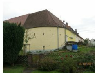
Polychrome Disharmonie von Putzstrukturen und Polychromer Gestaltung
