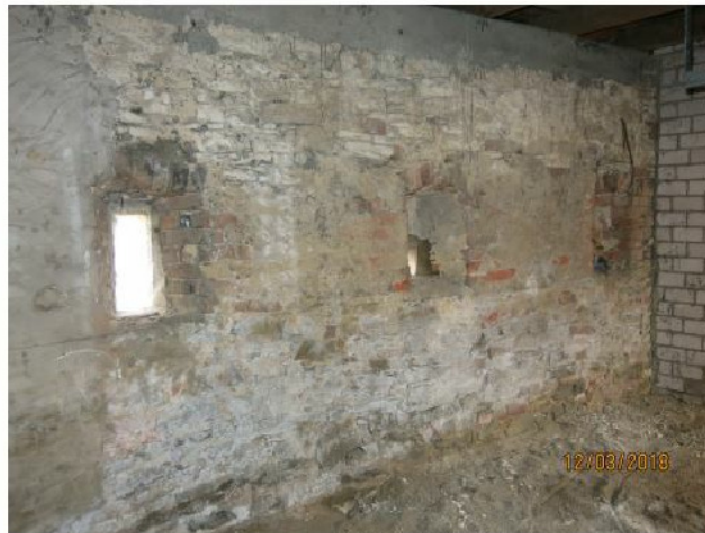
Innenraumansicht Bestand Nord-West 2018; IMG_4204.jpg
