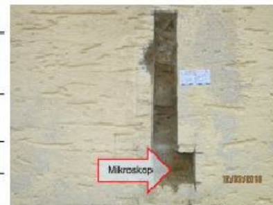
Detailaufnahme Putzaufbau IMG_4200.jpg
